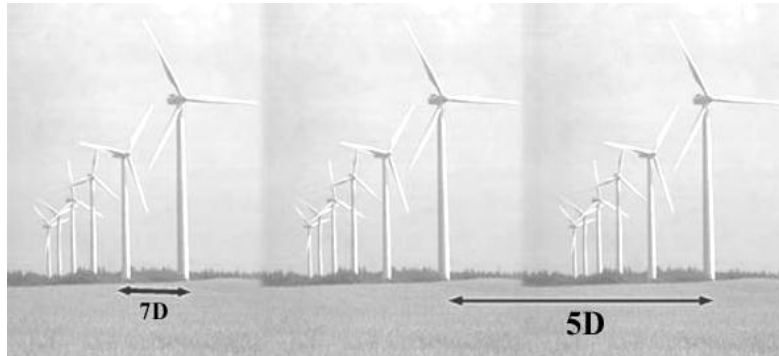
Sl. 11. Rastojanje između vetrogeneratora
