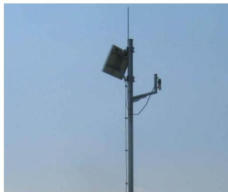
Slika 3. Fotonaponski paneli i antena WiFi AP
